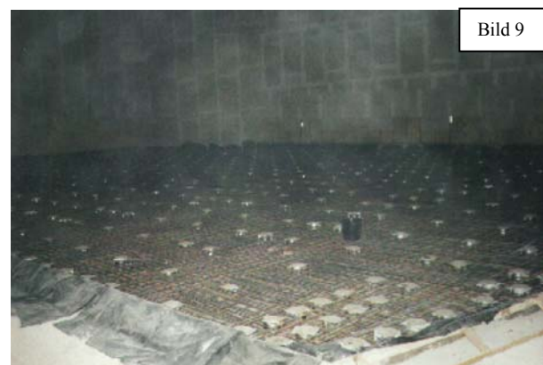
2. Einbringen der Bewehrung
